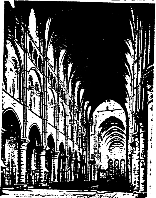
8-35 NOTRE DAME. Laon. Nave. 1160-1205. (Archives Photographiques)
